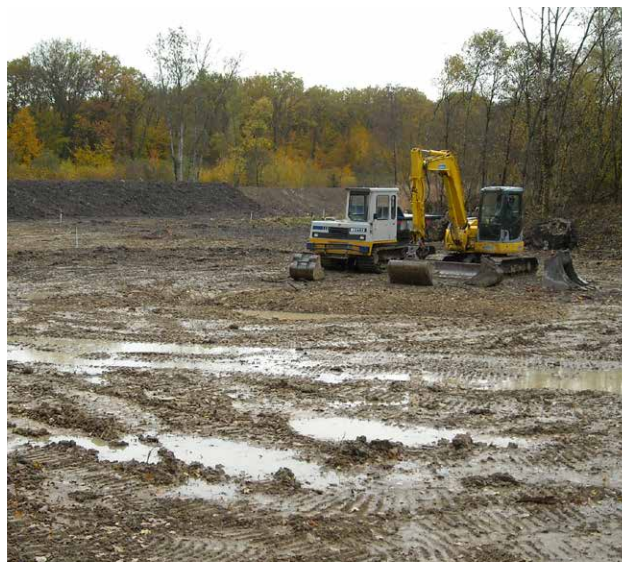
Vue depuis un observatoire des importants travaux d'agrandissement de l'étang des Douves.
