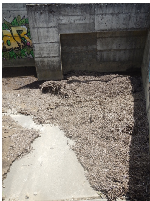
figure 8. Erosions et déchets de vignes apportés dans le décanteur n°1 avec les précipitations du 15 juin 2019.
